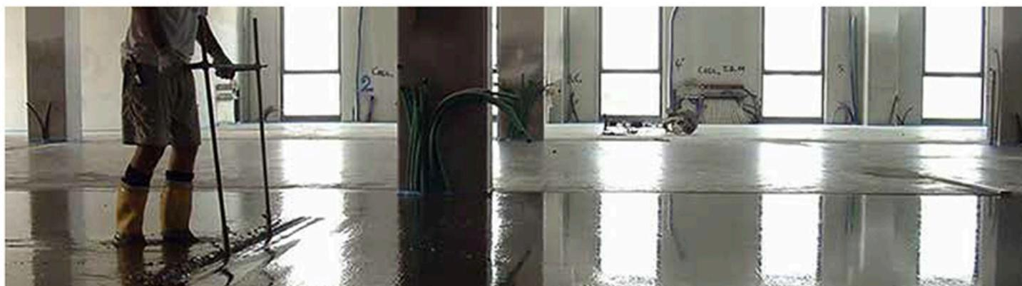
Il massetto fluido **Fluoplan®** è costituito da materiali tradizionali ma selezionati: sabbia, cemento, acqua e due additivi: Fluoplan P (polvere) e Fluoplan L (liquido).
